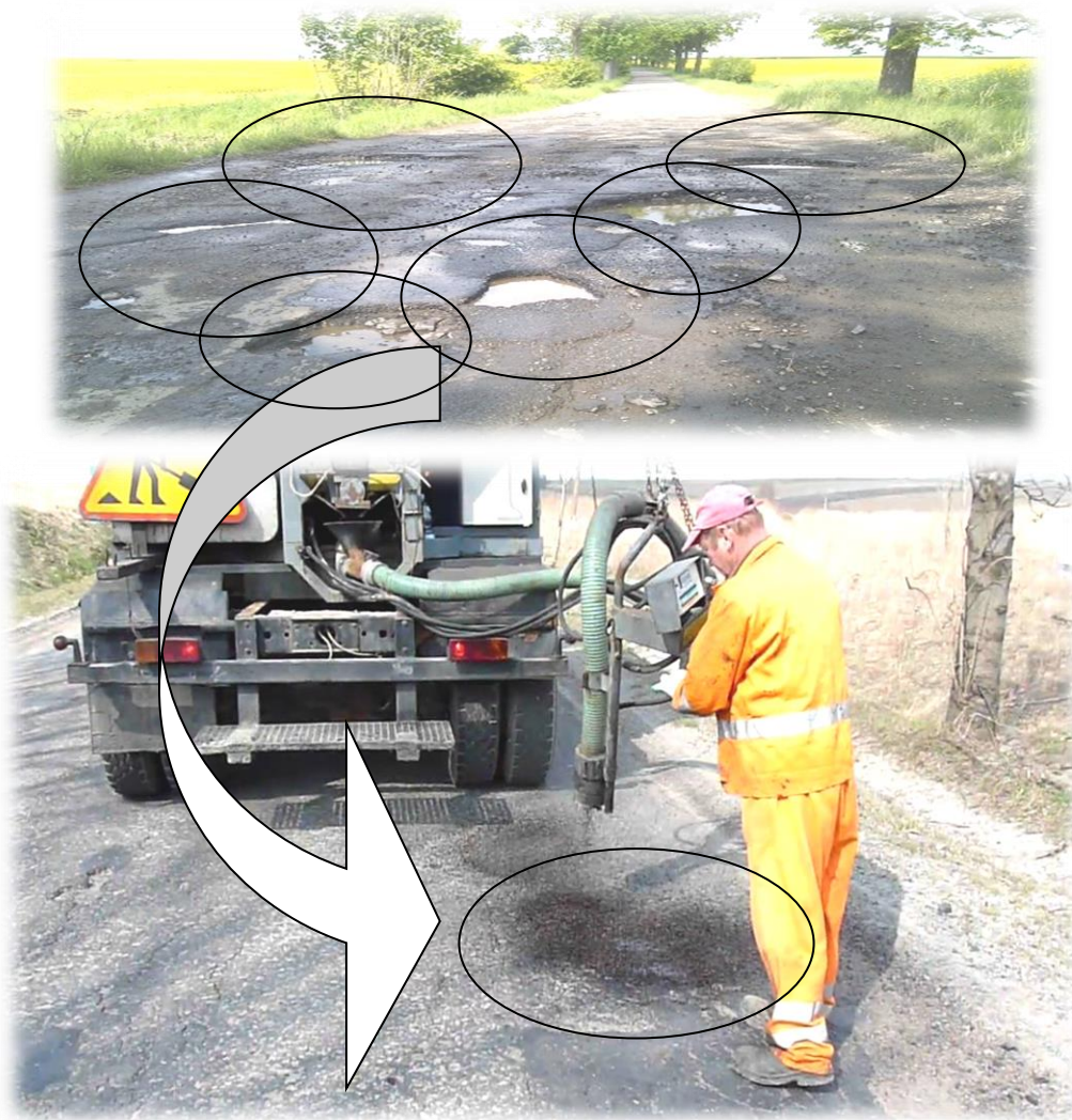
Rys. Natrysk mieszaniną gorącej emulsji asfaltowej i grys, wykonywany przez operatora remontera drogowego (patchera).
