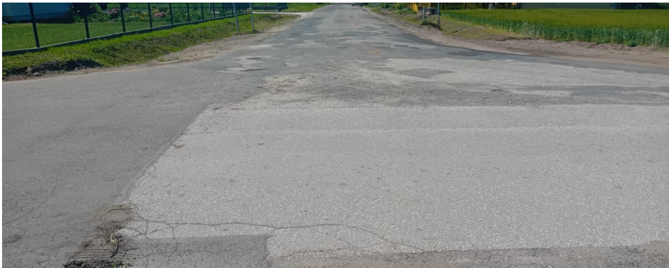
Zdjęcie nr 2. Przebieg drogi w miejscu gdzie wykonana zostanie nakładka dwuwarstwowa
