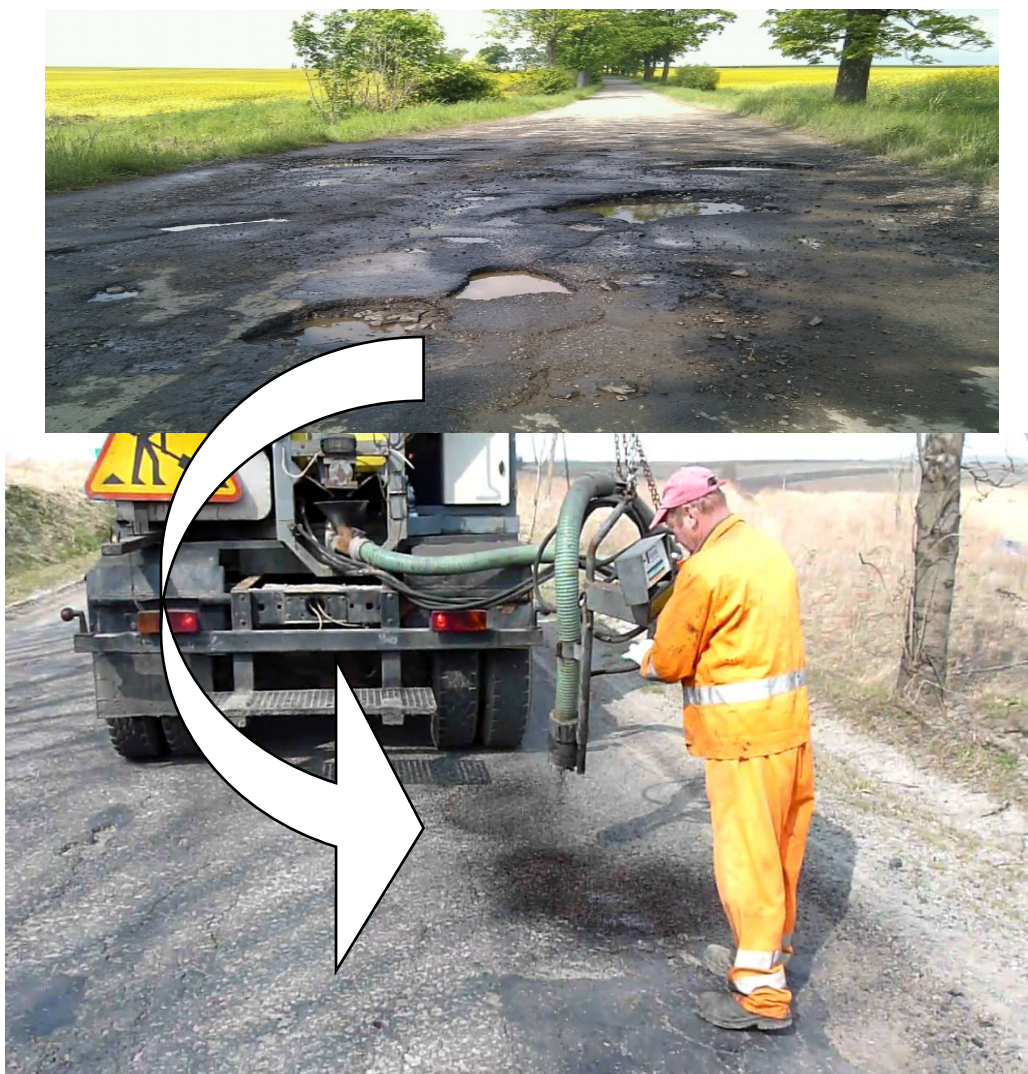
Rys. Natrysk mieszaniną gorącej emulsji asfaltowej i grysu, wykonywany przez operatora remontera drogowego (patchera).
