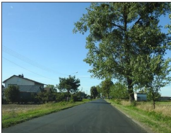
Fot. 1 Widok na teren omawianej inwestycji – km około 0+720
