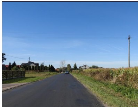
Fot. 2 Widok na teren omawianej inwestycji – km około 1+120
